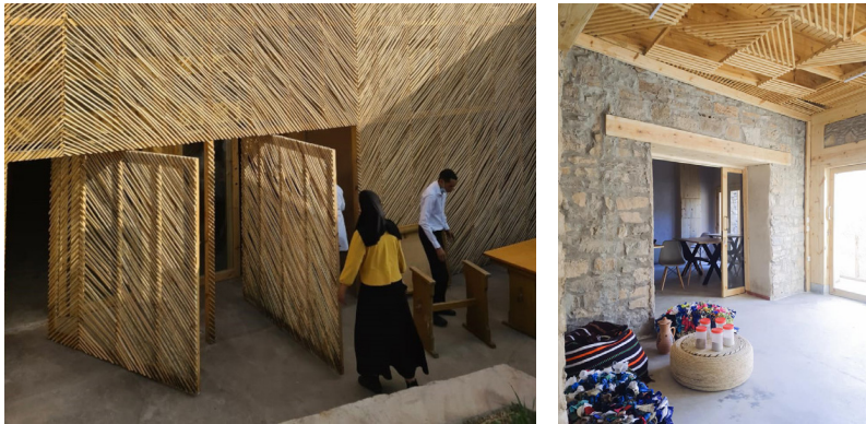
Bâtiment bioclimatique construit par le Centre Info énergie (CIE) de Tata.
