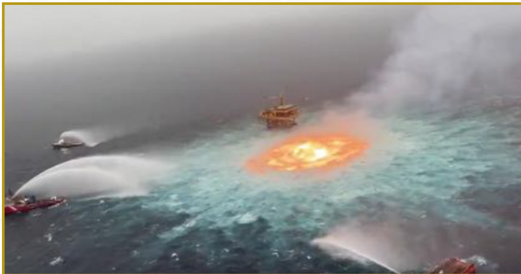
Figure 8 : un cas d'explosion causée par la rupture d'un gazoduc sous-marin
