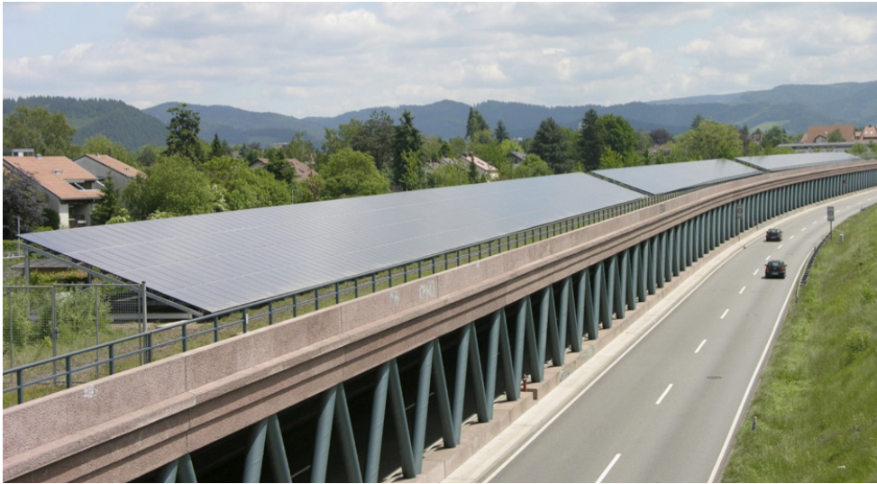
Une batterie de PV appartenant à la collectivité sur un mur anti-bruit à Fribourg, Allemagne Source: fesa GmbH 2006
